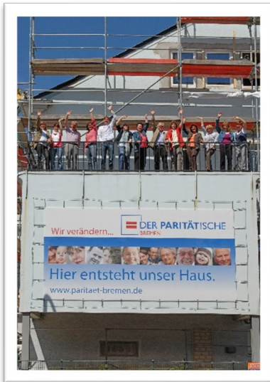
2009: Das neue Verbandshaus entsteht (Bild: Kerstin Rolfes)
